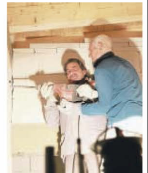
Herbert Uhlmann (links) und Franz Schallenberg helfen beim Innenausbau.
