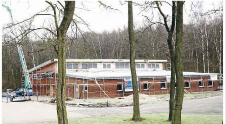
Das neue MTV-Sportzentrum fügt sich gut in das Gelände am Ende der Jahnstraße ein.
